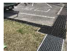
防滑塗装施工例 （グレーチング）
