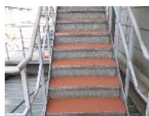
防滑塗装施工例 （屋外階段）
