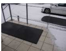
融雪マット設置例 （屋外通路）
