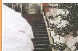
融雪マット設置例 （屋外階段）
